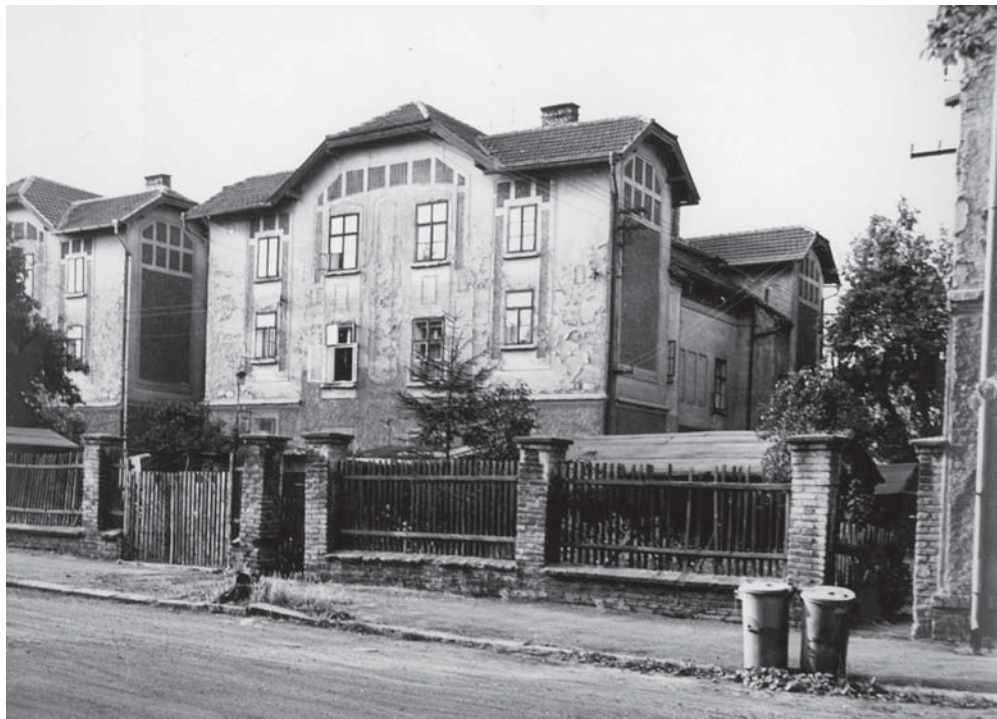
Obrázek 2: Karlov krátce před demolicí v roce 1986
