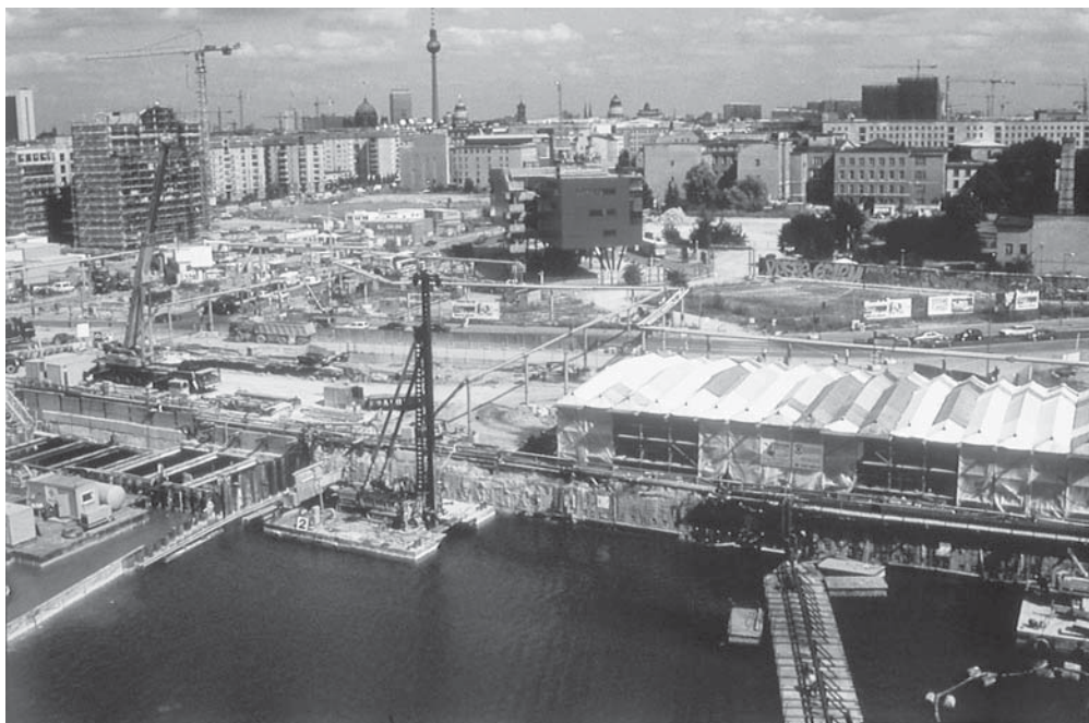
Obrázek 7: Staveniště na Postupimském náměstí, INFO BOX (1995)
