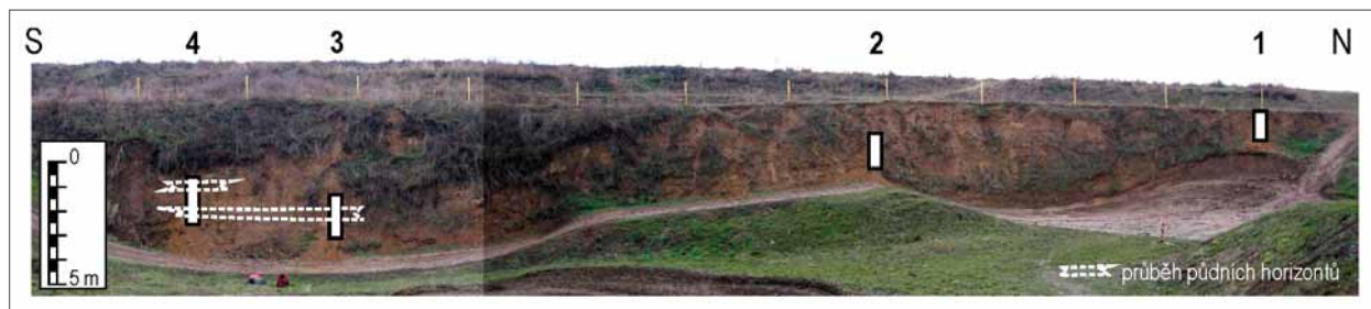
Obr. 2: Fotografie z. stěny bývalé těžebny, kde byly začištěny dílčí zářezy (1–4), ze kterých byly odebrány vzorky.
