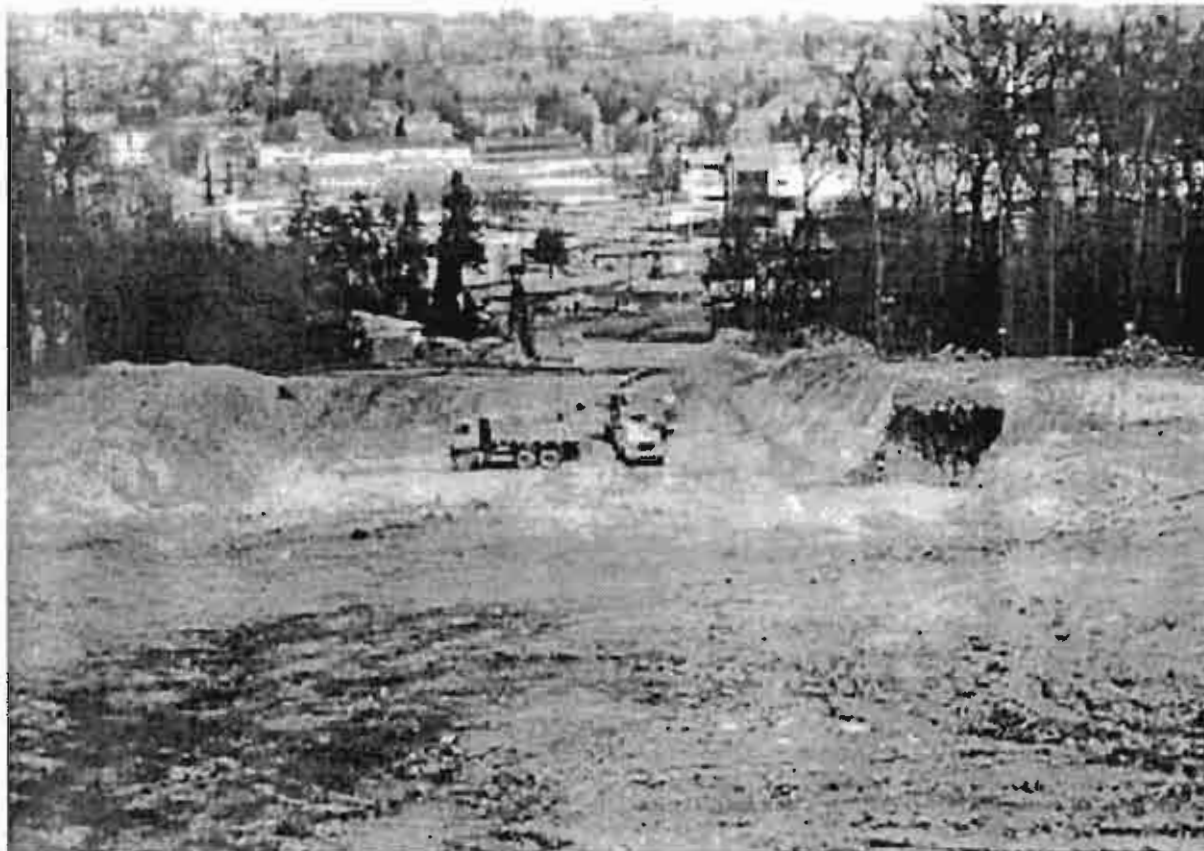
Foto 1 Pisárky. Celkový pohled na průkop pro pražskou radiálu pod svahem Strážné. Foto K. Válocha
