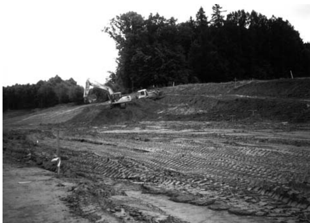
Obr. 2: Celkový pohled - severní část stavebního zářezu (foto T. Rozehnal).
