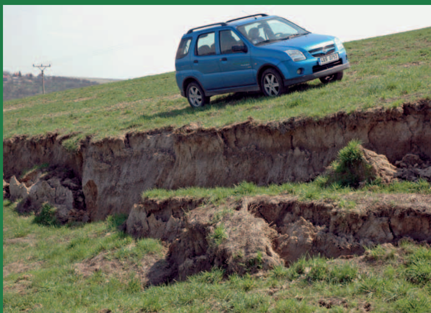
Pohled na část odlučné hrany nově vzniklého sesuvu v roce 2006 v Halenkovicích na Zlínsku. Autor O. Krejčí, 2006.
