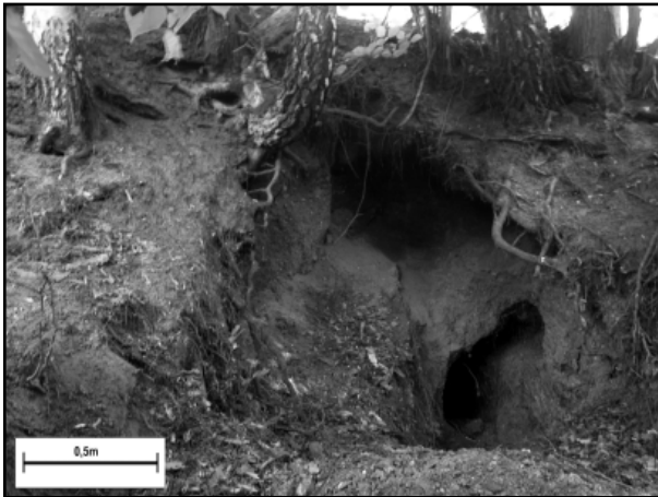
Obr. 2: Pozůstatky štoly, současný stav (fotografie z května 2011). Fig. 2: The remains of the gallery in its present form (photo, May 2011).
