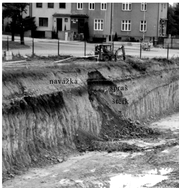
Obr. 1 – Nárazový břeh západněji položené terasy (foto z doby zakládání pilotů - kolektiv techniků firmy Unistav a.s.). Fig. 1 – Cut-bank of the west situated terrace (photo - team of the Unistav a.s. technicians).
