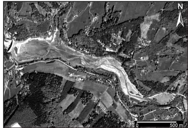
Obr. 2: Letecké ortofotografie výplně přehradní nádrže Bystřička (zdroj: aplikace GoogleEarth).
