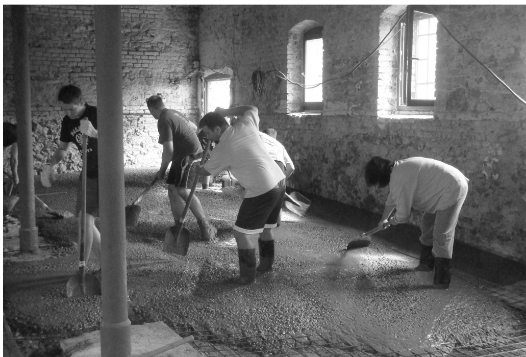
Obr. 9. Upravujeme interiér muzea. Domíchávač přivezl a vysypal první hromadu betonu na podlahu. Všichni jsme se chopili lopat a srovnávali hustou kašovitou hmotu, než ztvrdne. Foto: B. Klíma.
