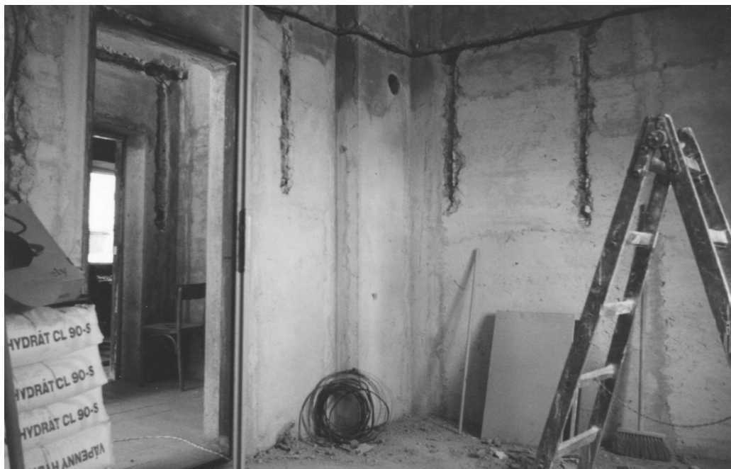
Obr. 5. Opravovaný interiér ubikace studentů s novou hrubou omítkou je připraven pro zabudování elektroinstalace. Foto: P. Čermáková.
