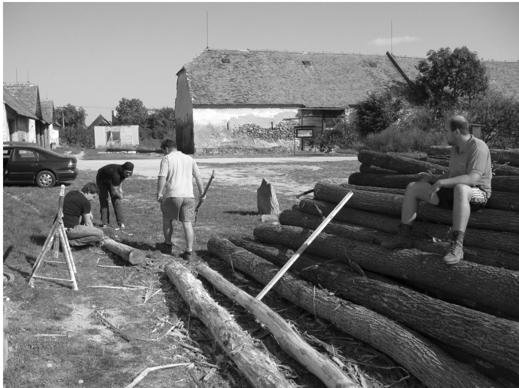
Obr. 5. Odstraňování kůry pořízy a sekerami z dubových kmenů, které vytvoří stěny budovaných sídlištních objektů.
