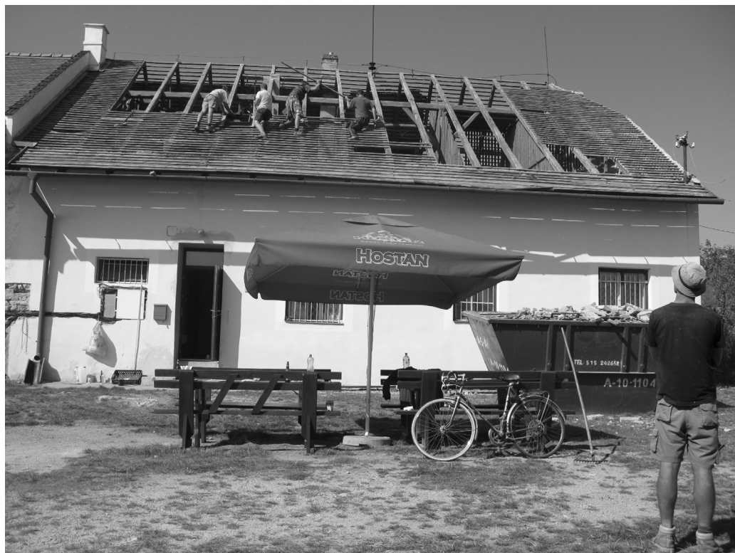
Obr. 6. Účastníci jedné z víkendových brigád při opravě střechy a výměně krytiny na hlavní budově archeologické expedice.
