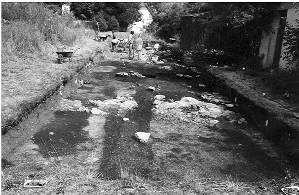
Obr. 7. Tmavá výkopová rýha prvního křížovnického vodovodu prochází středem výzkumu ke klášteru. Zasahuje do žlutého, drolivého skalního podloží.
