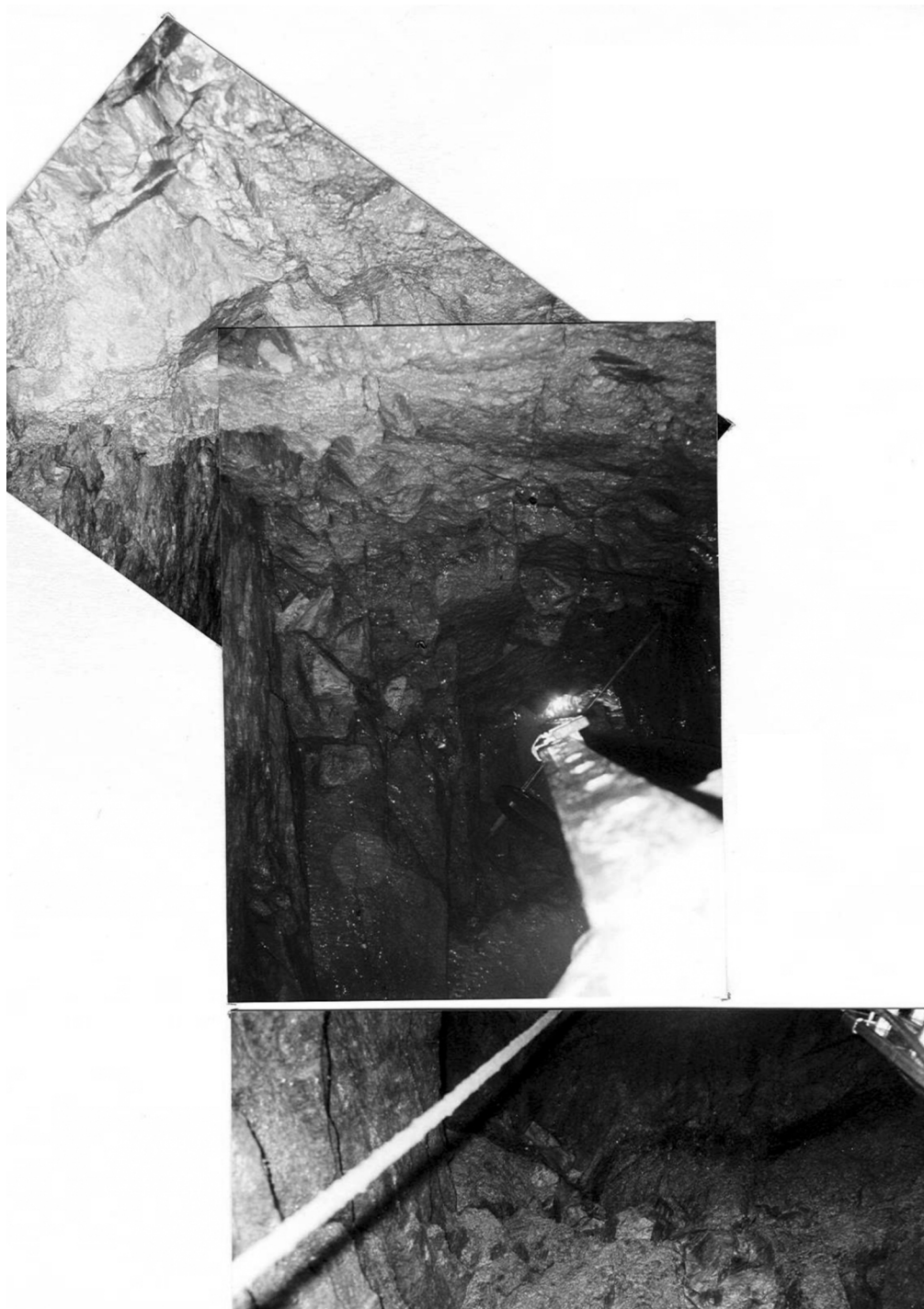
Obr. 5. Znojmo-Hradiště. Pohled shora do skalní cisterny, složený ze tří samostatných fotografií.
