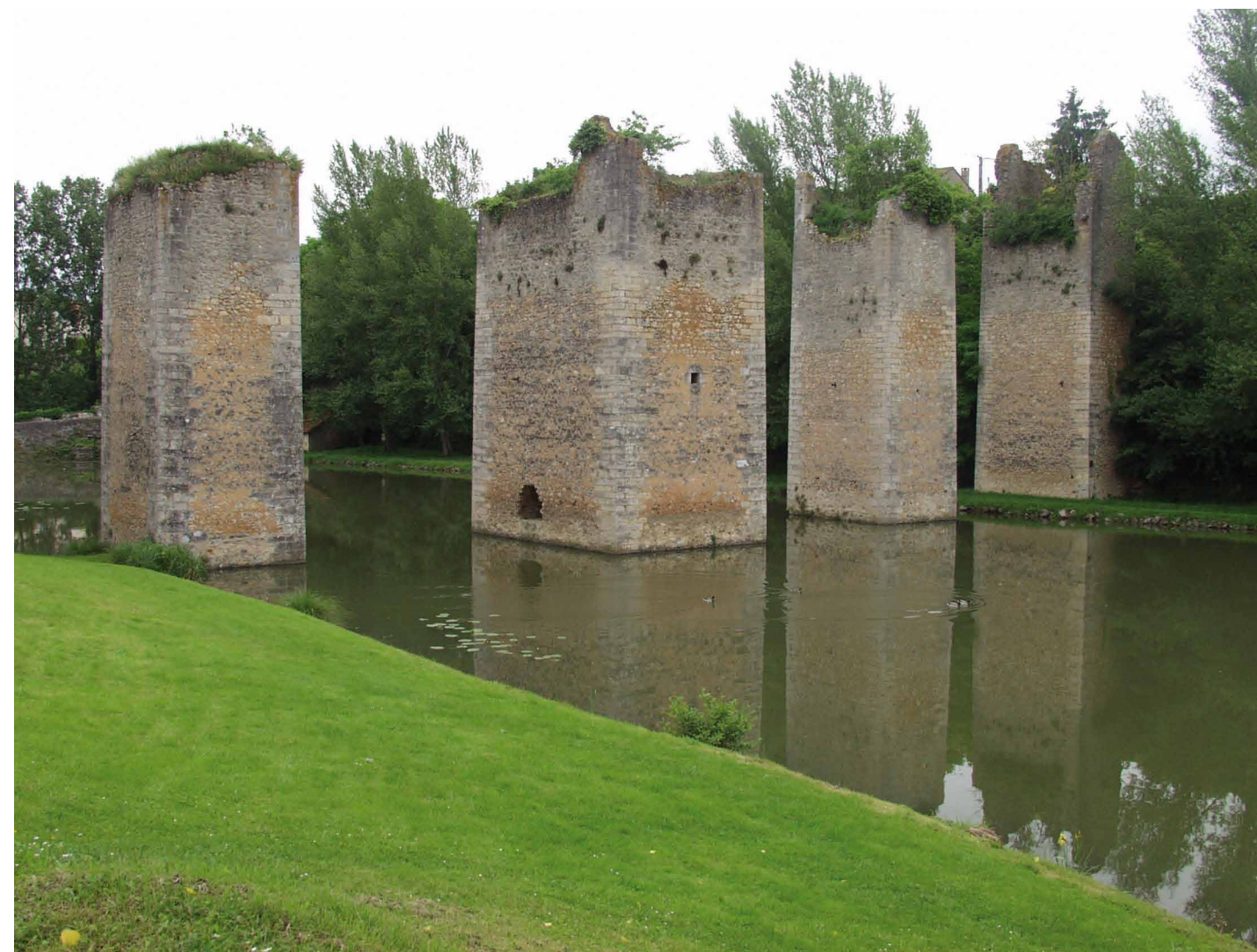
Při zachování původního účelu se hrad transformuje v opevněný most uprostřed rybníka. Největší stavba (druhá zleva) je v podstatě donjon, ostatní tři jsou pilíře mostu. La Marche, Francie 2008.
