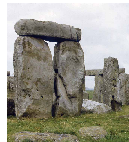
Megality – kromlech ve Stonehenge. Architektura právě vstoupila do služeb kultu – a ne ledajakého. Petrografické studie dokládají, že až padesátitunové bloky se na místo dopravovaly z velkých vzdáleností (30 km a 160 km), i když technika transportu není zcela objasněna. Tak či onak, po uzavření symbolického kruhu už s kameny nikdo nehne. Anglie 1986.
