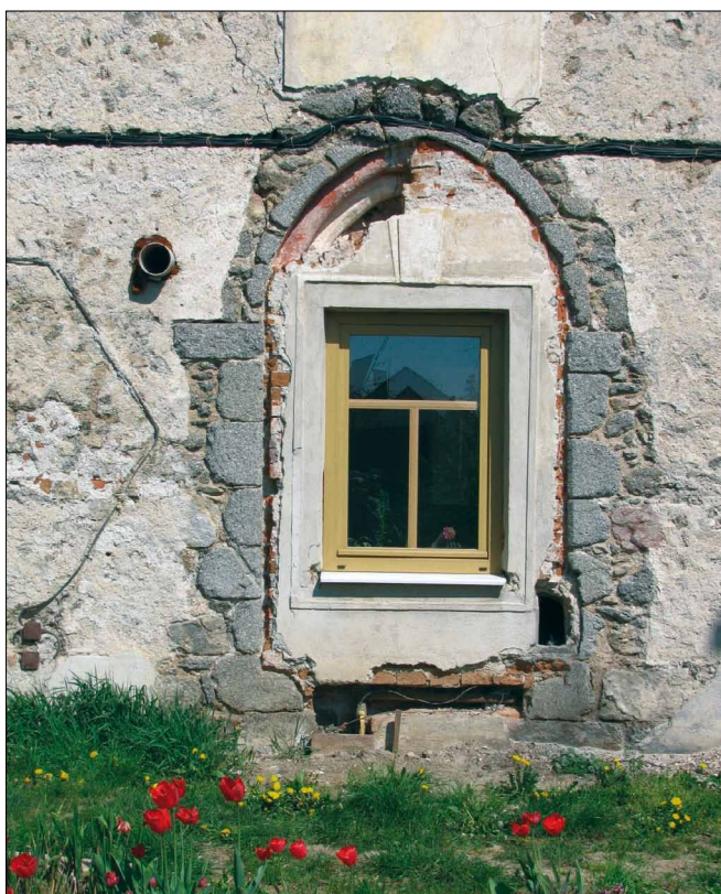
Obr. 2. Částečně odkrytý raně gotický portál.
