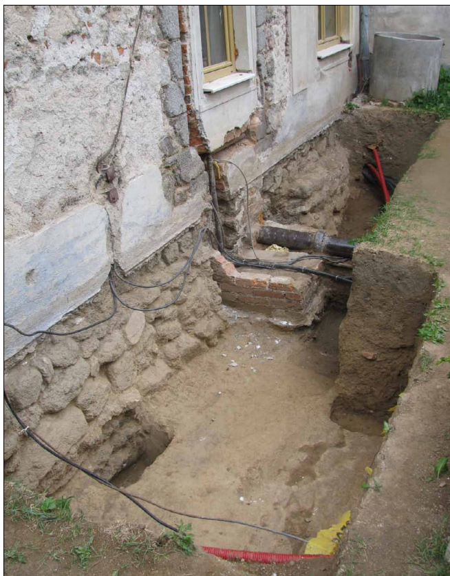
Obr. 61. Celkový pohled na S.XVI/12 od jihozápadu po exkavaci hrobů.
